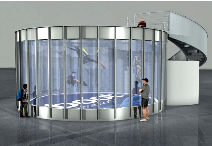
Abbildung 21 Neuer Tauchturm mit 200.000 l Wasser. Steht man direkt vor einem der 24 Acrylsegmente, hat man einen guten Blick auf das Unterwasser-Geschehen im Inneren. Foto: Jürgen Sütterlin
