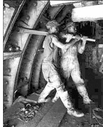
Abb. 2: Um das Eindringen des Hudson-Wassers zu verhindern, herrschten in der Überdruck-Arbeitskammer Drücke bis über 3 bar. Daher konnten die Arbeiter nur eine gewisse Zeit in der Arbeitskammer verbringen
