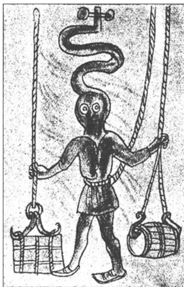
Abb. 4: Wie in der ersten Hälfte des 15. Jahrhunderts der Aufenthalt unter Wasser gelöst werden sollte. Die Luftversorgung über ein Schlauchsystem, dessen offenes Ende mit Schwimmern an der Wasseroberfläche gehalten wurde, funktionierte wegen der Druckdifferenz zwischen intrathorakalem Raum und Wasseroberfläche nicht.
