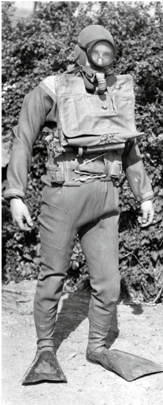
Abbildung 1 Royal Navy Frogman equipped with „Davis apparatus“ Sauerstoff-Rebreather mit Pendelatmung (Foto: British Royal Navy, 1945).
