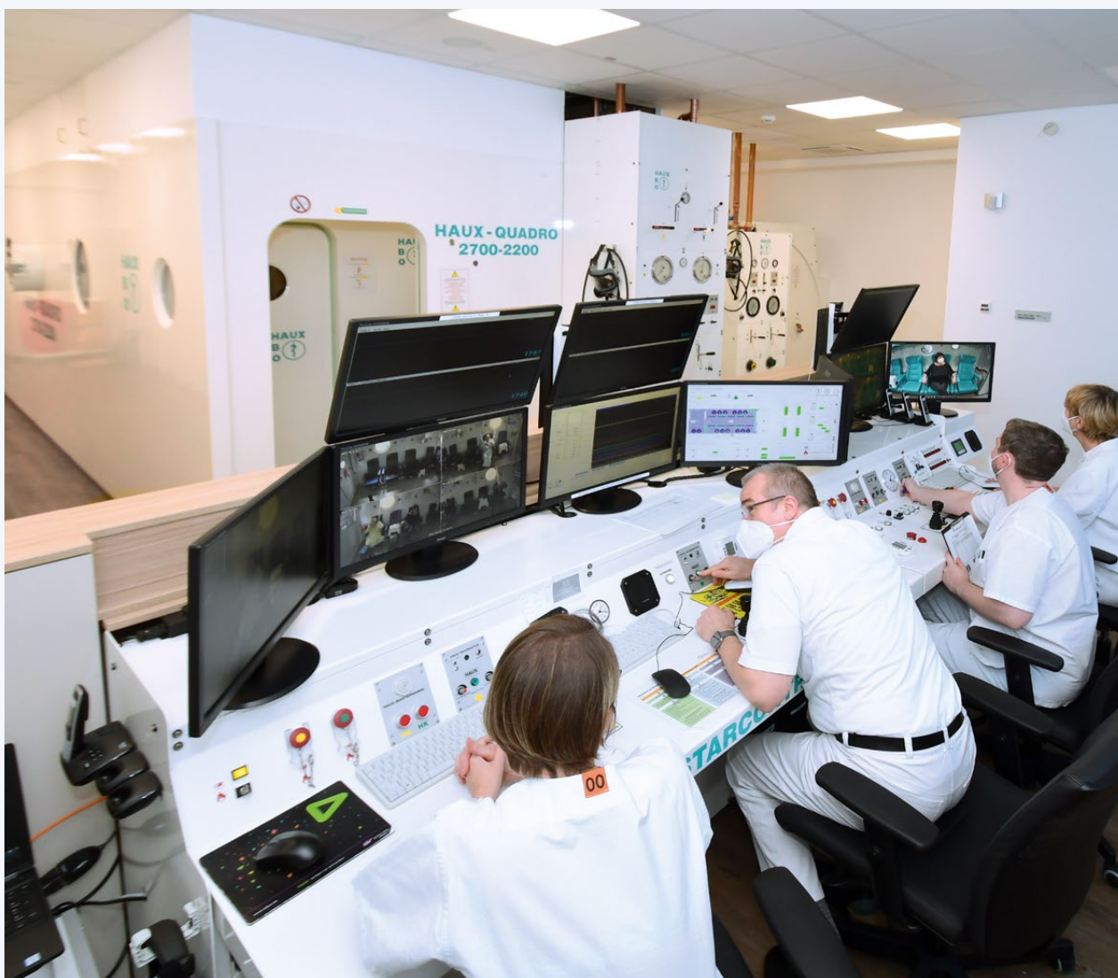
Abbildung: Steuer- und Überwachungsstand für die zwei HBO-Druckkammern der HBO-Abteilung im BKB Gelsenkirchen-Buer. Im Hintergrund die beiden Druckkammern mit pneumatischen Fahrständen. Näheres s. Artikel in diesem Caisson ab S. 14. (Foto: Zentrum für Hyperbare Sauerstofftherapie / Bergmannsheil und Kinderklinik Buer GmbH)
